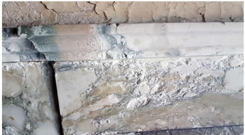
Deterioros causados por la cristalización de sales en revestimiento de mármol y muro adyacente. Fuente: Equipo de trabajo
