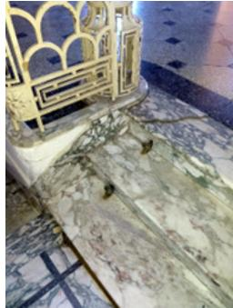
Fisuras en distintas placas de mármol, provocado por la disolución de zonas débiles en la roca o por movimientos de los muros bajo las placas
