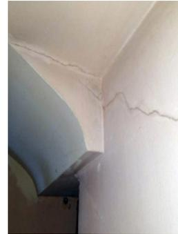
Muro bajo escalera: Grieta en muro de carga por debajo de la escalera
