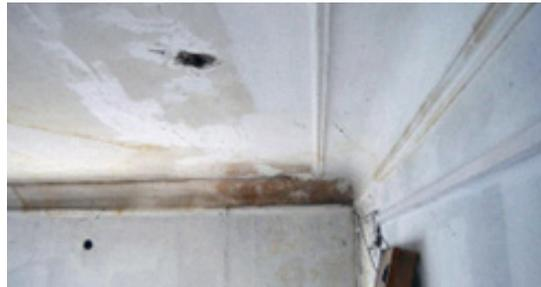
Pueden observarse manchas de humedad en el mismo cielorraso, por lo que se recomendó evaluar el estado de losa dada la corrosión de la armadura.
