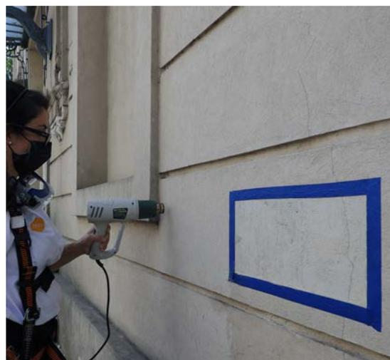
Aplicación de técnicas para limpieza y remoción de revestimiento plástico. Fuente: Equipo de trabajo
